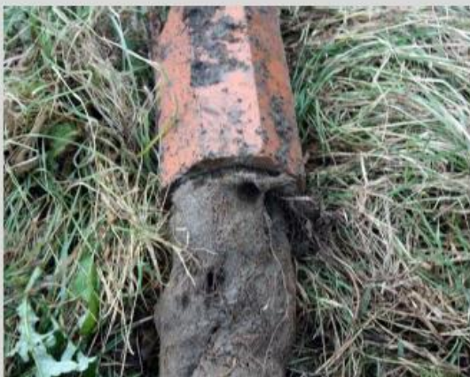
Obr. 4 / Vlevo: Účinek kombinace zarůstání průtočného profilu kořeny bylin a zanášení splaveninami z drenážní vody (foto: M. Čmelík) Vpravo: Příklad instalace záslepky (případně clony) na drénu, kdy je PVC záslepka vložena do stávajícího drénu z pálené hlíny, průměru 0,13 m. (foto: M. Soukup)
