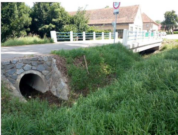
Obr. Silniční most na Žejbru v Synčanech. Mostní profil částečně zanesen sedimenty, vpravo stávající odlehčovací koryto.
