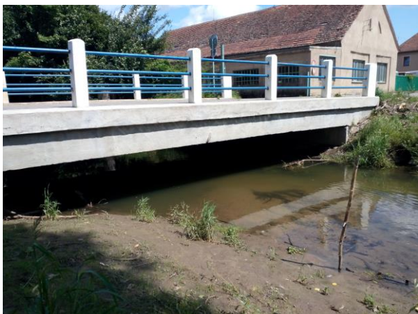
Obr. Silniční most na Žejbru v Synčanech. Mostní profil částečně zanesen sedimenty, vpravo stávající odlehčovací koryto.
