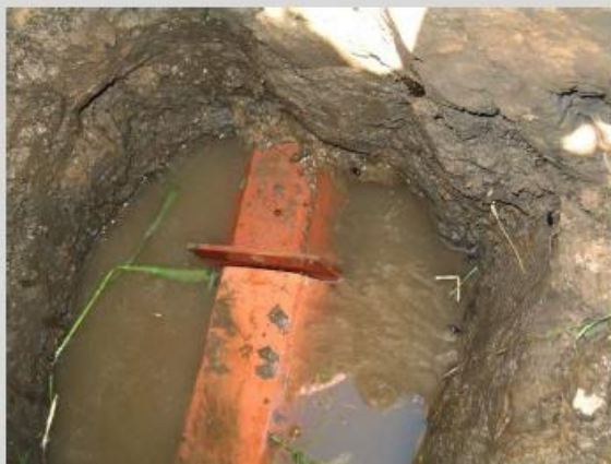
Obr. 4 / Vlevo: Účinek kombinace zarůstání průtočného profilu kořeny bylin a zanášení splaveninami z drenážní vody (foto: M. Čmelík) Vpravo: Příklad instalace záslepky (případně clony) na drénu, kdy je PVC záslepka vložena do stávajícího drénu z pálené hlíny, průměru 0,13 m. (foto: M. Soukup)
